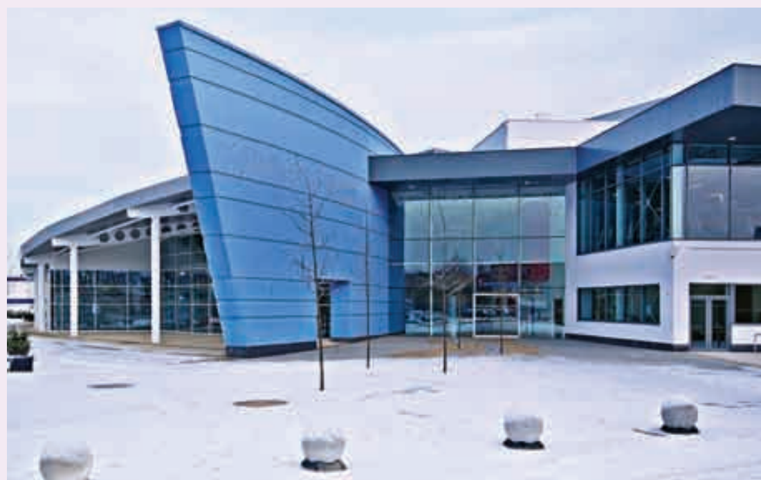
Развлекательный центр Bletchley Leisure Centre (г. Блетчли, Великобритания). Архитекторы: Holder Mathias Architects, строительная компания: SDC for Milton Keynes Council. Проектом предусмотрены особые мероприятия в целях минимизации расходов, связанных с реальным ущербом для окружающей среды от экономической деятельности. Например, путем включения в проект котельной на биомассе и сокращения потребления воды там, где это возможно. Сертификат: BREEAM Bespoke, рейтинг Excellent
